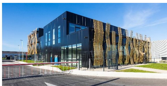
Le chai d'assemblage et les chais de stockage et de vieillissement de cognac développés sur 15 000m 2 pour Distillerie de la Tour à Merpins (16). Livré décembre 2021.
