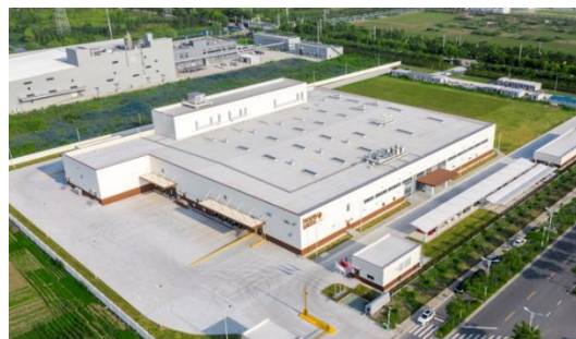
L'unité de fabrication d'ingrédients alimentaires de 11 300m 2 pour Newly Weds Foods à Nantong (en Chine). Livraison été 2021.
