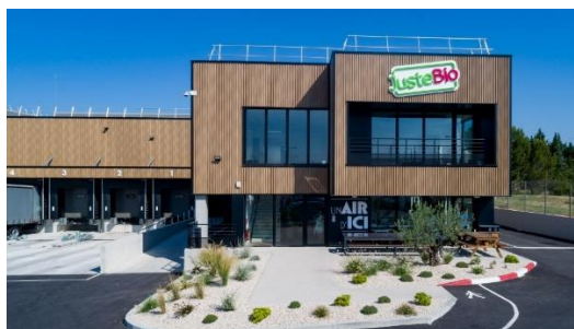
Le site de conditionnement de fruits secs en vrac de 7 000m 2 pour Un Air d'ici (Juste Bio) à Carpentras (84). Livré en octobre 2020.
