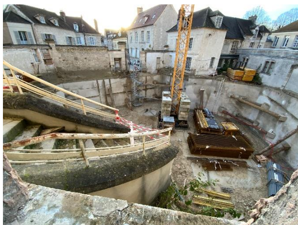
Un parking – ici en cours de réalisation - réparti sur deux niveaux de sous-sol est prévu sous l'édifice
