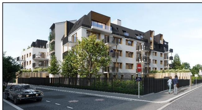
Rénovation Masséna – 60 log. Crédit © : A19 Architecture
